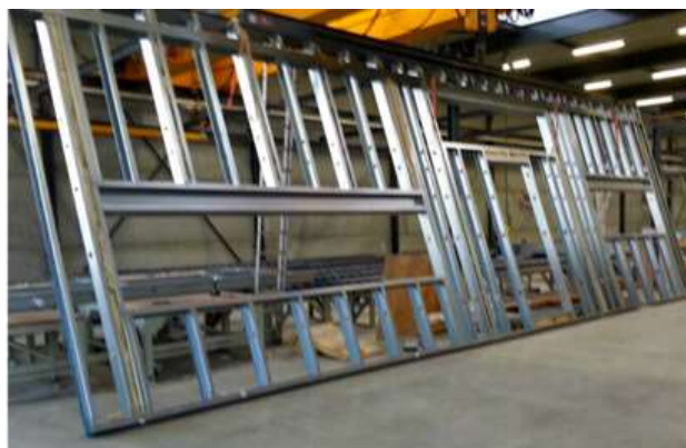
Figuur 18: Staalframebouw (Industrieel bouwen, sd)
