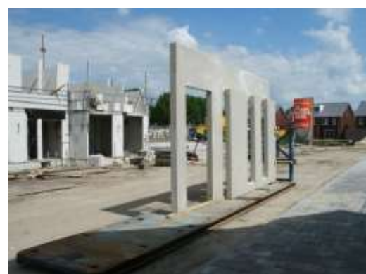
Figuur 16: Geprefabriceerde betonnen gevels (Berkela, sd)
