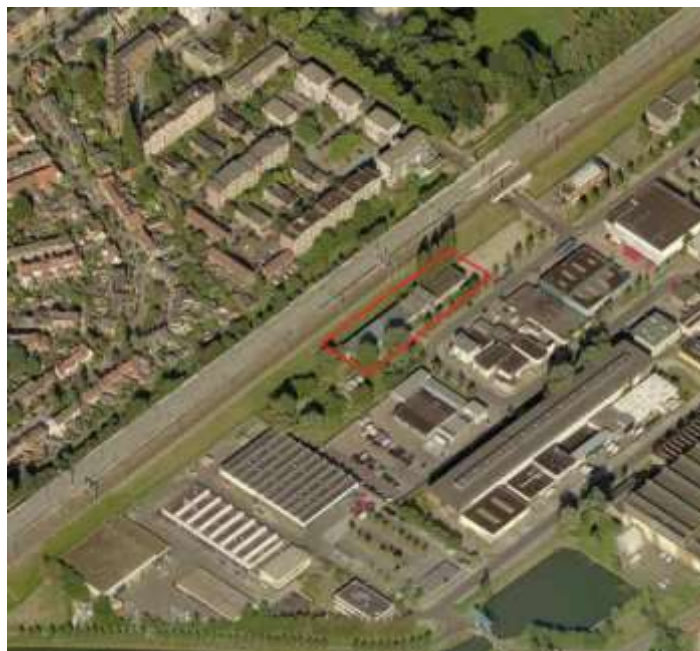
Figuur 1: Projectlocatie Vlampijpateliers (Google Maps, 2019)
