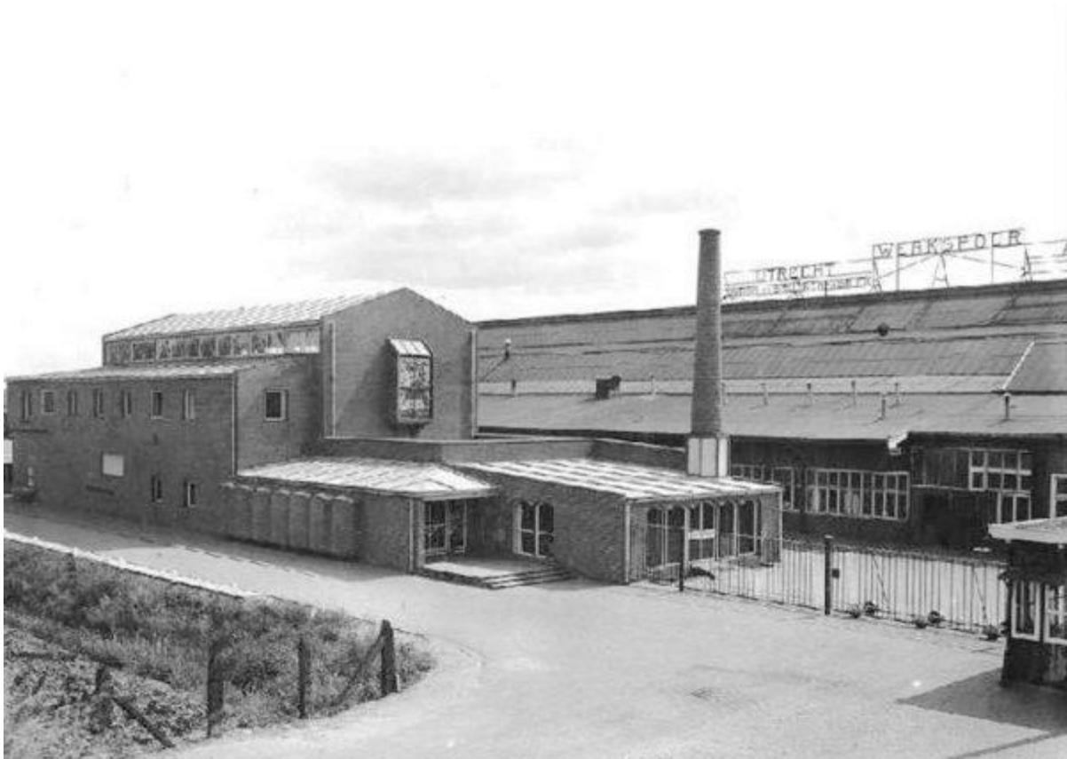
Figuur 10. Het ontspanningsgebouw van Werkspoor, omstreeks 1940. Het gebouw doet nu dienst als partycentrum. De markante schoorsteen werd in 2011 afgebroken, maar werd in het voorjaar van 2018 weer in ere hersteld. Bron: https://erfgoedstem.nl/herstel-schoorsteen-werkspoor-utrecht-sluit-aan-bij-europees-erfgoedjaar/ .
