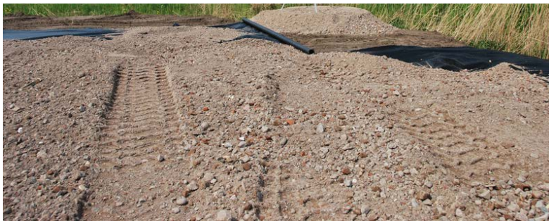
Afbeelding 4.5 Een fundering van gebroken puin
