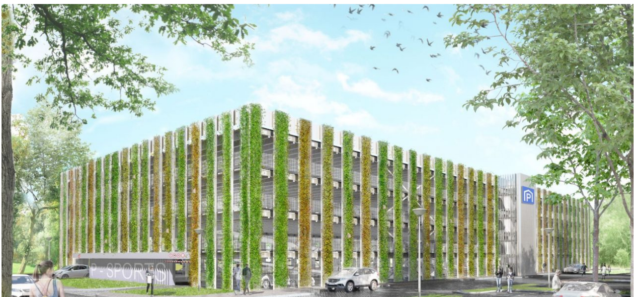
Afbeelding 5.1 Nieuwe demontabele parkeerconstructie P-sports TU Delft (TU Delft, 2019)
