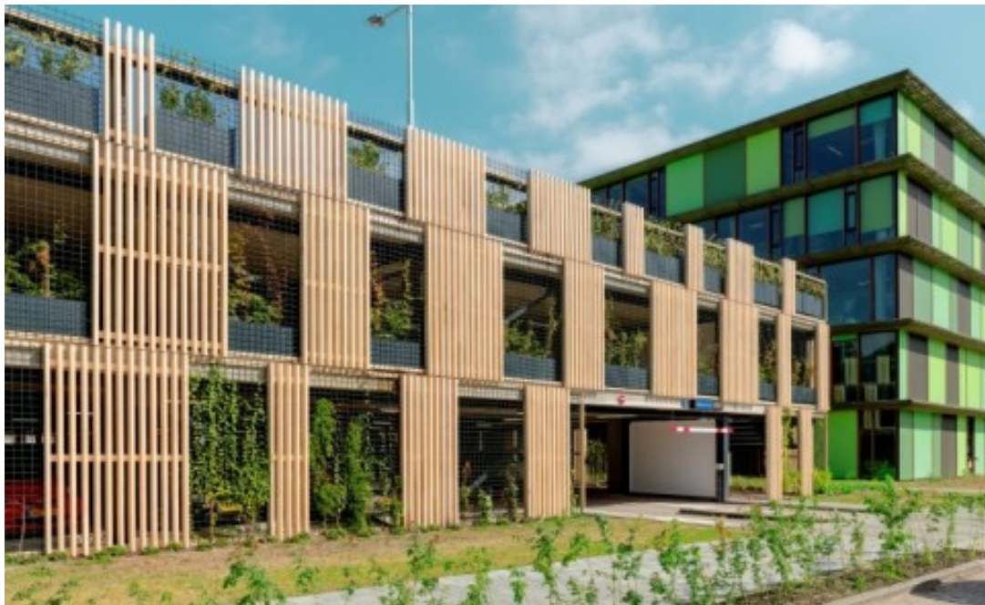
Afbeelding 5.2 Referentie demontabele parkeerconstructie Wageningen university research (EZ Park, 2018)
